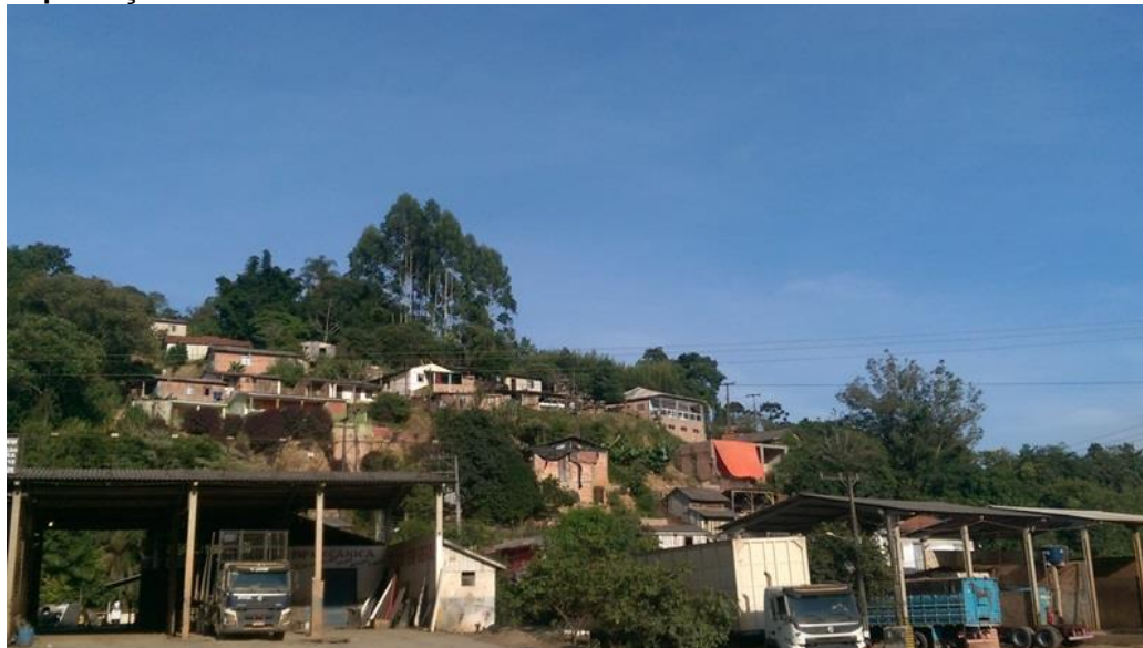
Figura 23: Encosta com risco muito alto, próximo a PR-160, situada no Bairro Vila Esperança.
