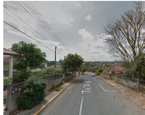
Travessa Angico: via com caixa insuficiente para a função estrutural.
