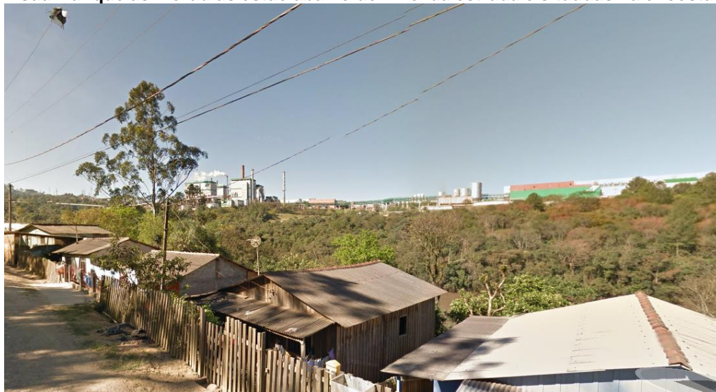
Figura 26: Moradias entre a Estrada dos Guararapes e margem do Rio Tibagi. Pode visualizar que as moradias estão abaixo do nível da estrada e situadas na encosta.
